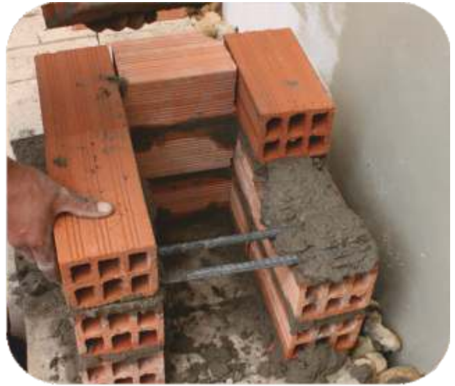
Fotografía 34: Construcción de la cámara de combustión
