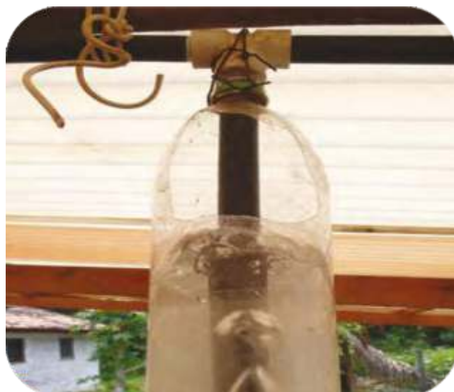
Fotografía 45: Válvula de seguridad dejando escapar el biogás debido a una presión excesiva
