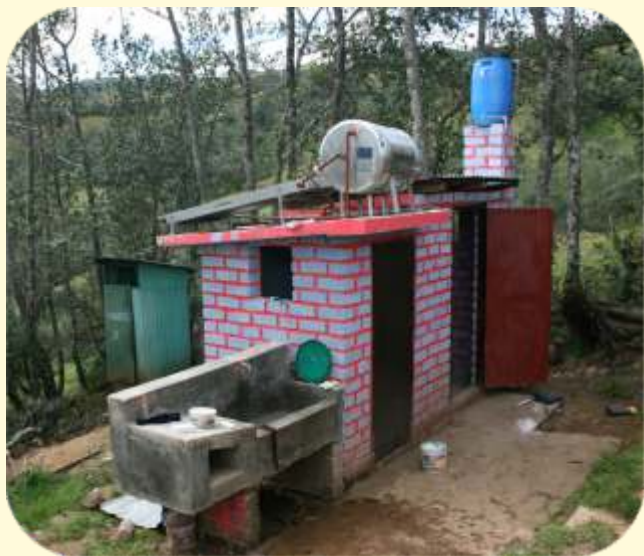
Fotografía 72: Sistema solar térmico para ducha de vivienda compartiendo estructura con BES y sistema solar térmico con 2 placas planas en paralelo en centro educativo
