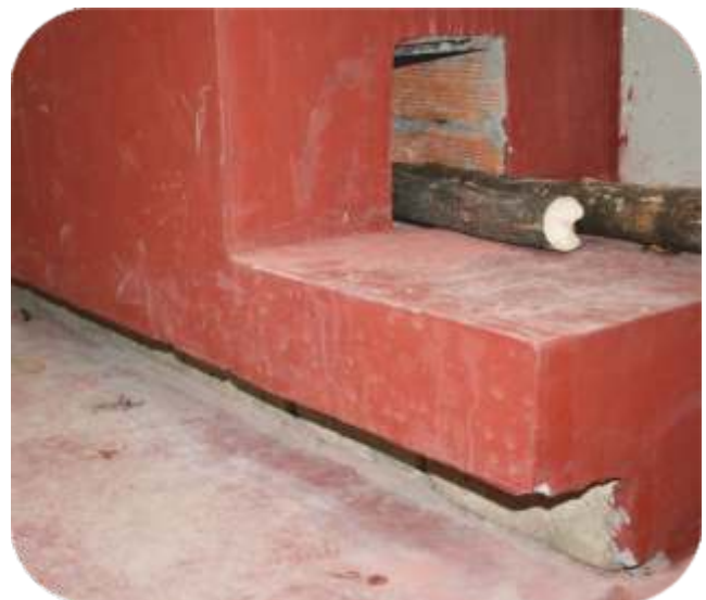
Fotografía 35: Estructura de la cocina
