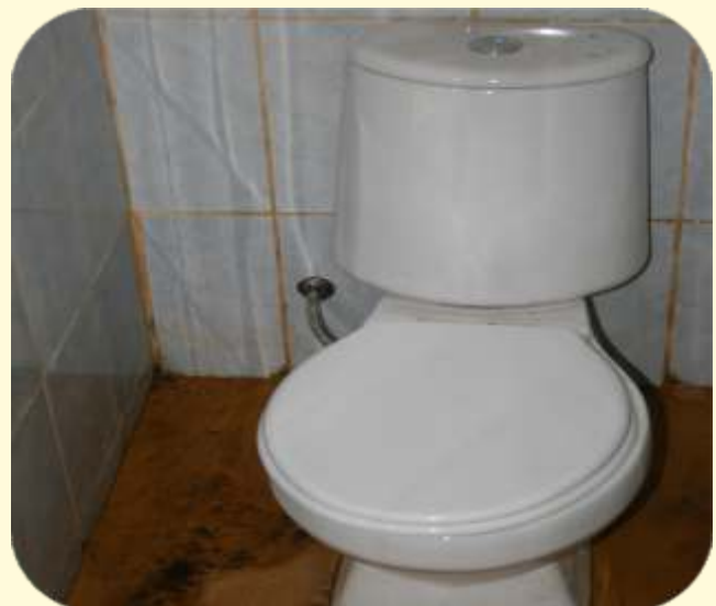
Fotografía 71: Módulo de baños y detalle de inodoro de arrastre hidráulico
