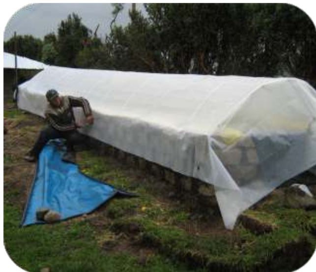
Fotografía 44: Colocación del techo invernadero sobre la estructura metálica en forma de cúpula
