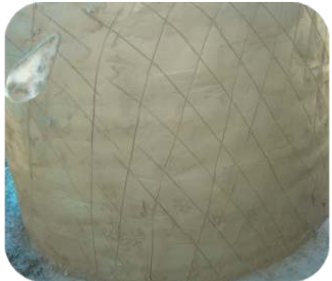
Fotografía 22: Bruñido sobre el mortero
