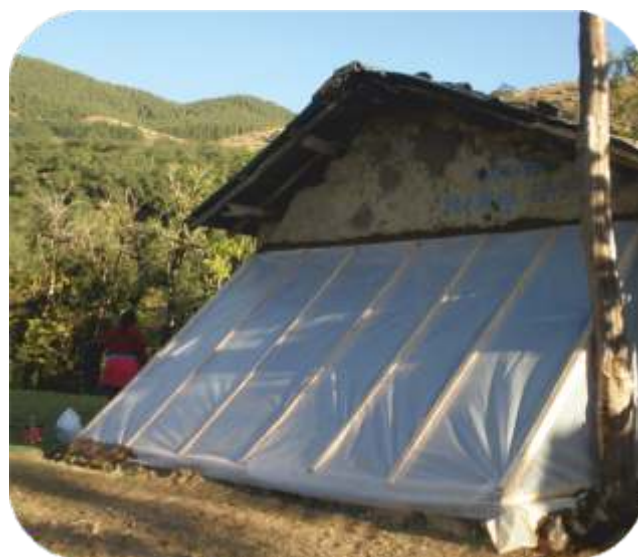
Fotografía 55: Muro Trombe terminado
