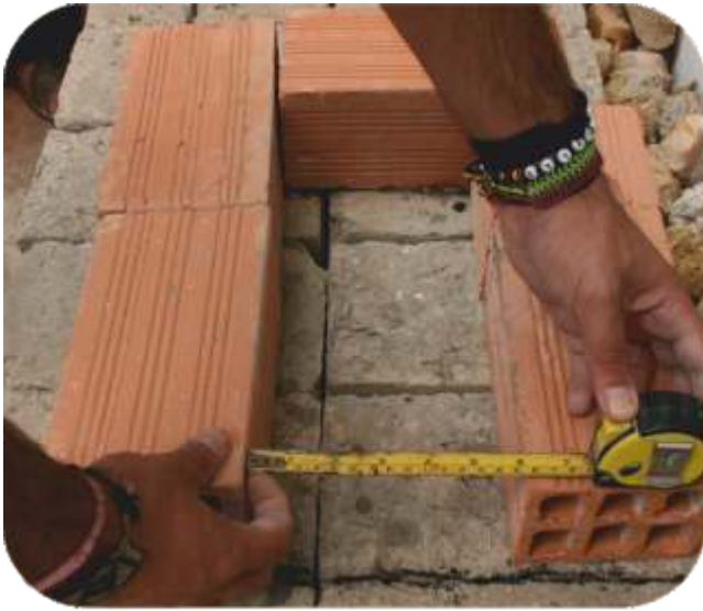
Fotografía 34: Construcción de la cámara de combustión
