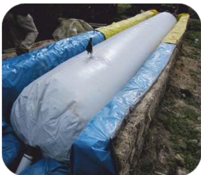
Fotografía 41: Reactor de geomembrana en proceso de instalación
