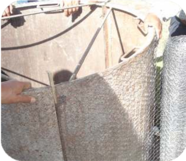
Fotografía 19: Malla sobre encofrado de acero
