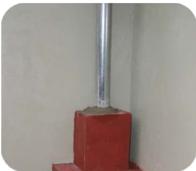
Fotografía 36: Base recubierta de la chimenea
