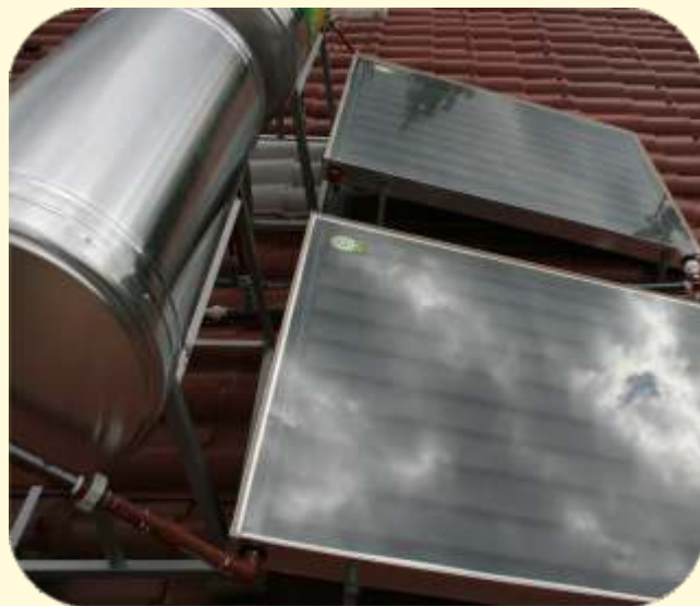
Fotografía 72: Sistema solar térmico para ducha de vivienda compartiendo estructura con BES y sistema solar térmico con 2 placas planas en paralelo en centro educativo
