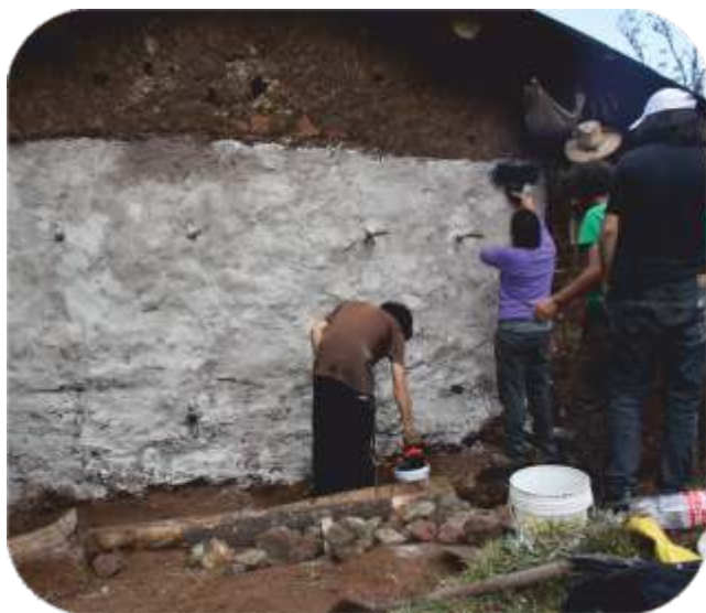
Fotografía 51: Enyesado de la pared
