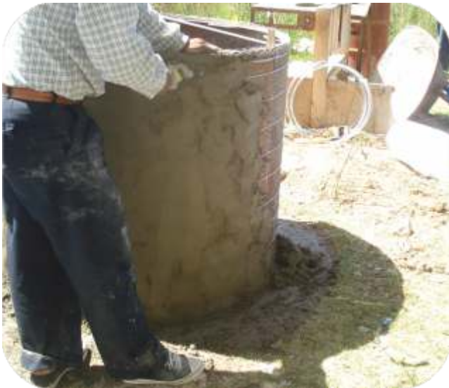
Fotografía 21: Colocación de la primera capa de mortero
