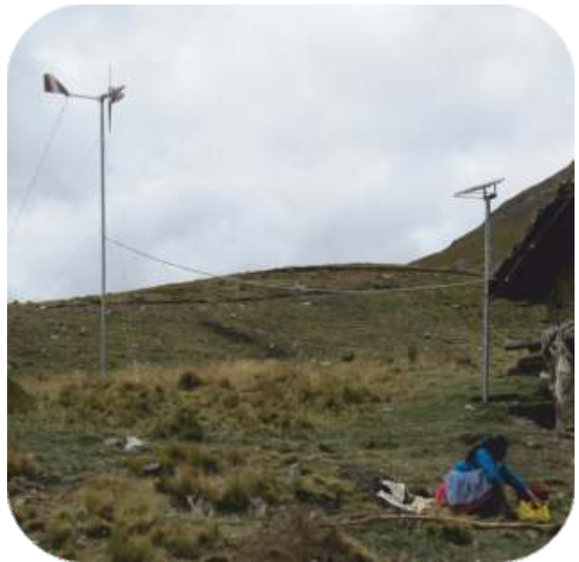
Fotografía 15: Sistema híbrido en la comunidad de Campo Alegre, Cajamarca.
