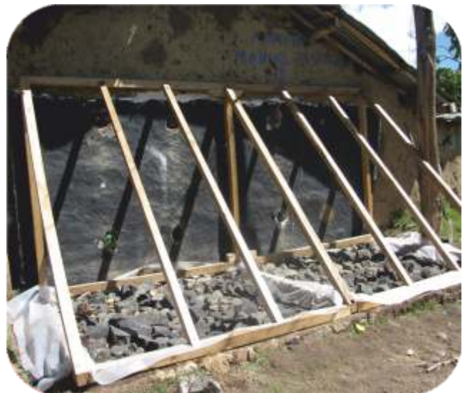
Fotografía 53: Armazón del muro Trombe
