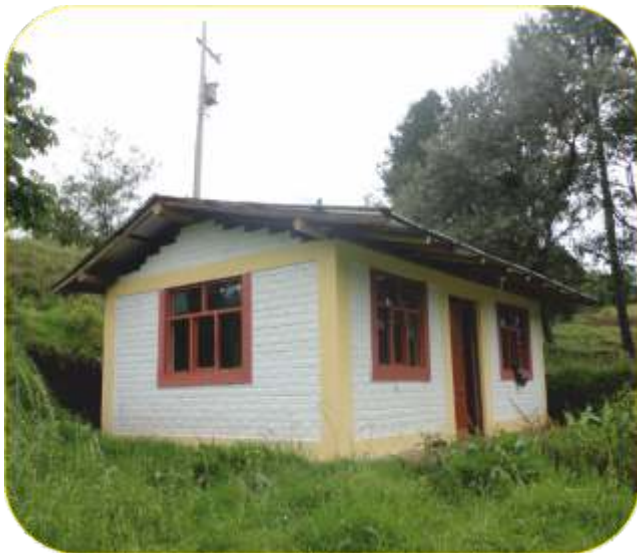
Fotografía 7: Casa de Máquinas
