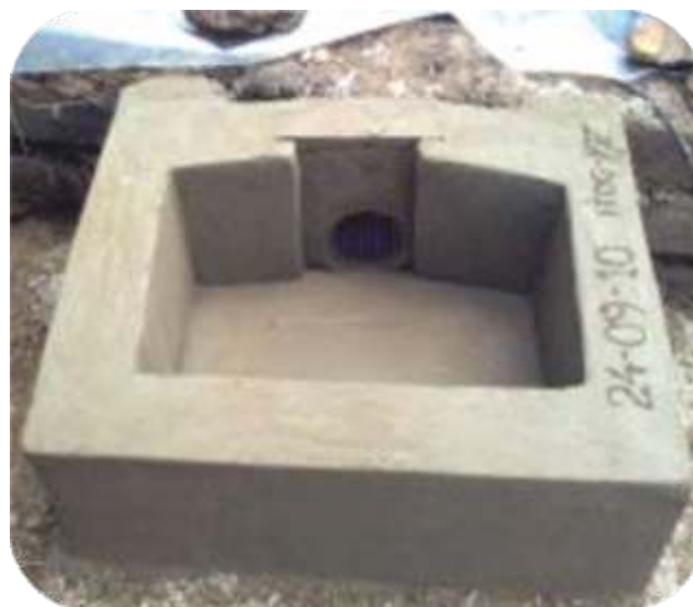
Fotografía 42: Poza de entrada con rejilla
