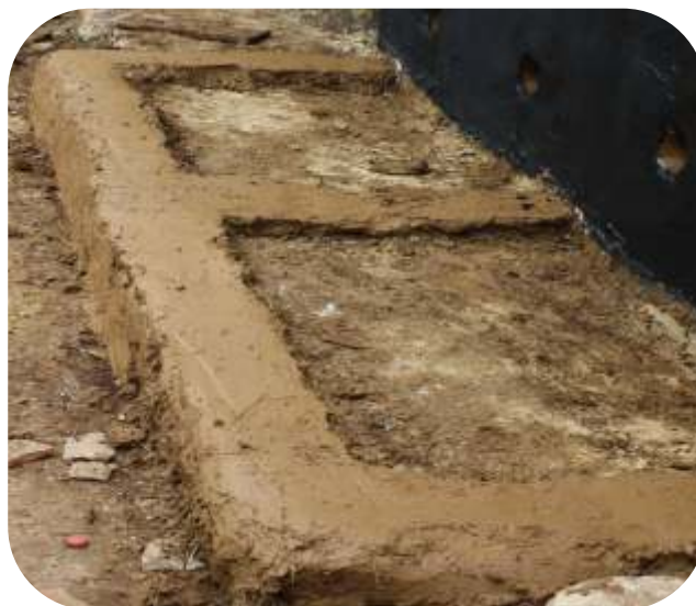
Fotografía 50: Muro de apoyo
