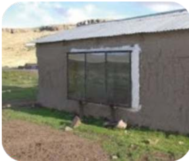
Fotografía 56: Muro Trombe vertical
