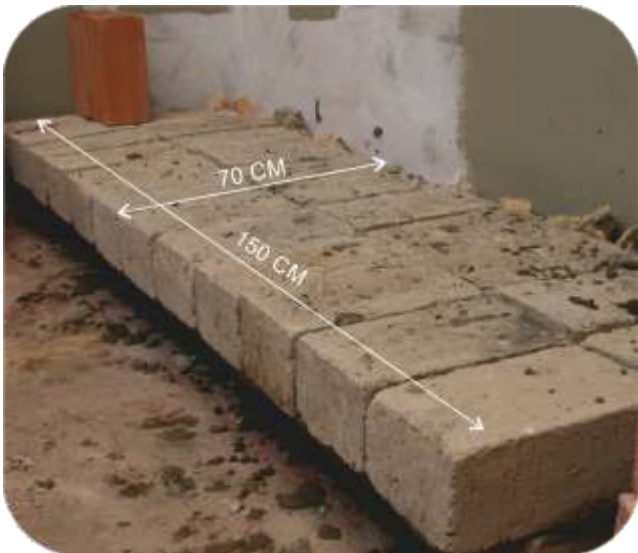
Fotografía 34: Base de la cocina
