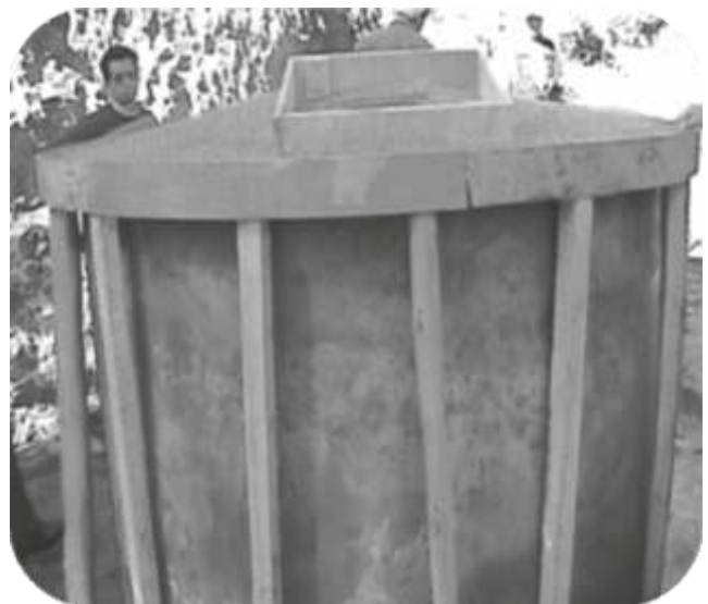
Fotografía 23: Encofrado de madera para techo
