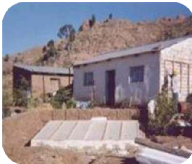
Fotografía 57: Muro Trombe horizontal
