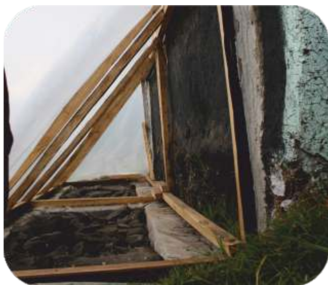
Fotografía 54: Interior Muro Trombe
