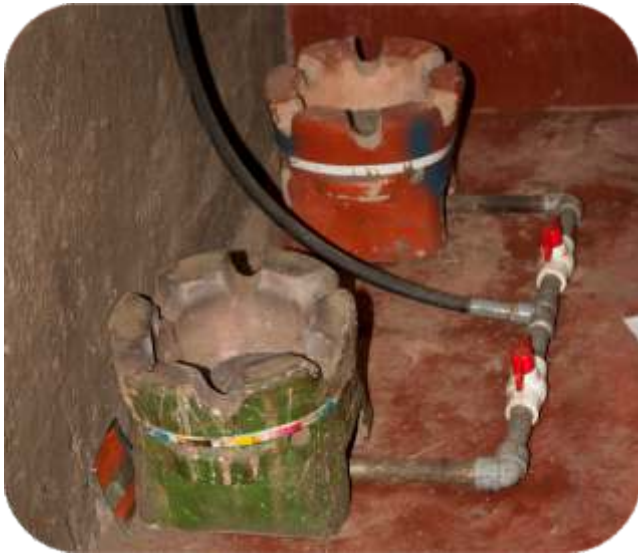
Fotografía 47: Cocina de biogas formada por 2 hornillas de arcilla
