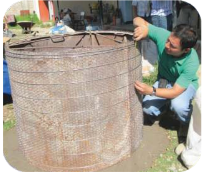
Fotografía 20: Refuerzo con hierro galvanizado.
