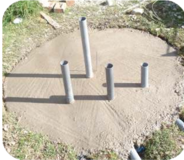
Fotografía 17: Vaciado de la cimentación con concreto.
