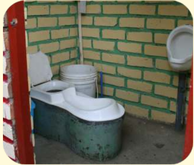
Fotografía 70: Interior de baño ecológico seco (BES)
