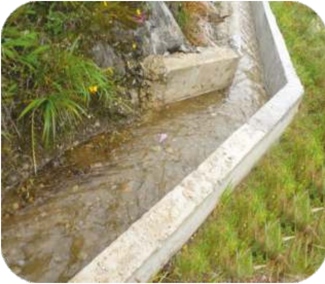
Fotografía 3: Canal de Conducción
