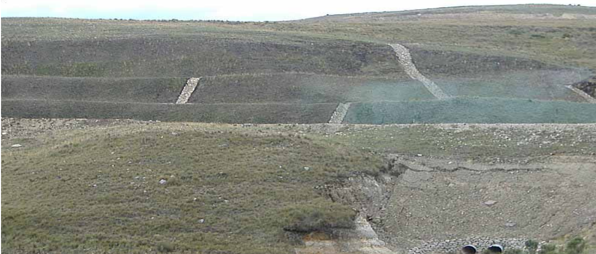
Figura 23: Vertedero de desmontes no PAG. La zona verde es aglutinante y todo esta revestido con una malla.
