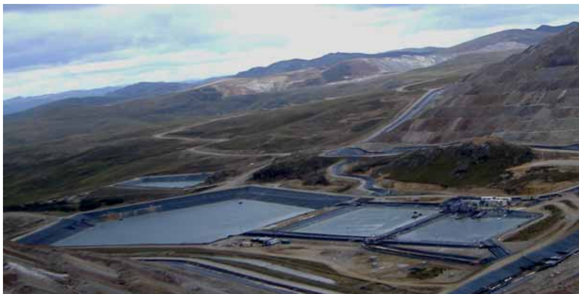
Figura 12: Embalse de almacenamiento de la disolución y embalses de control (la más pequeña es la de almacenamiento).
