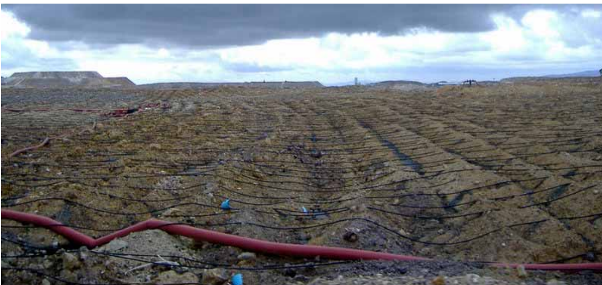
Figura 10: Fundación (base de una futura pila de lixiviación), con el sistema de tuberías descrito.
